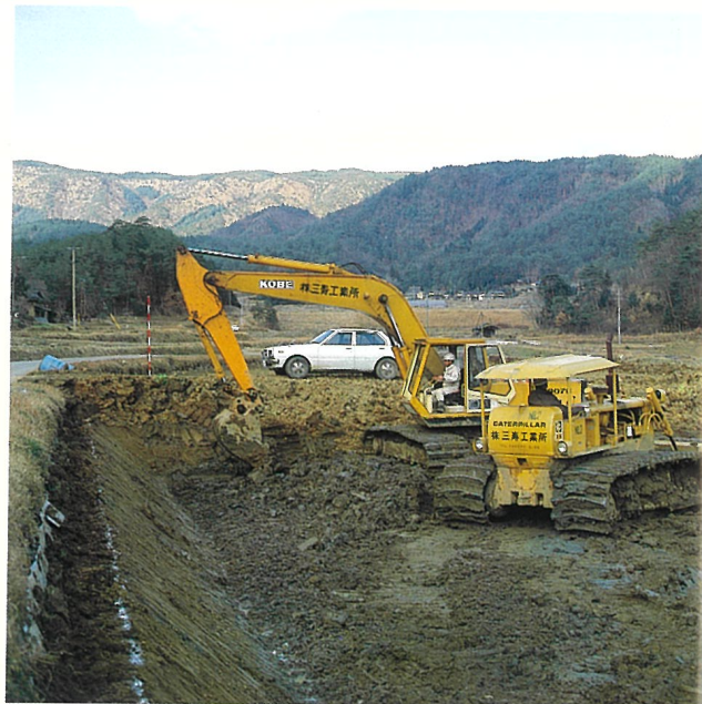
▲整備が進むほ場
